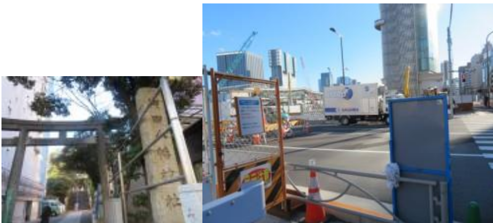
※御田神社、品川工事現場
